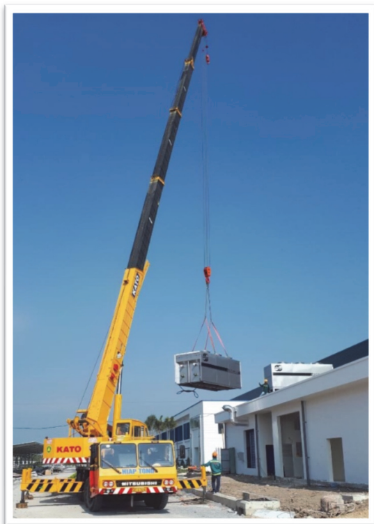
Lắp đặt dàn ngưng
