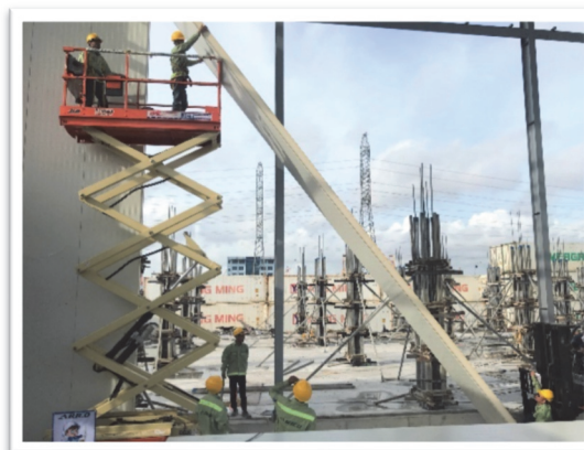
Lắp dựng kho lạnh
