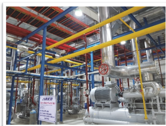
Lắp đặt hệ thống lạnh NH3
