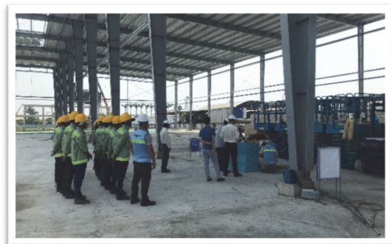
Chuẩn bị lắp dựng kho lạnh
