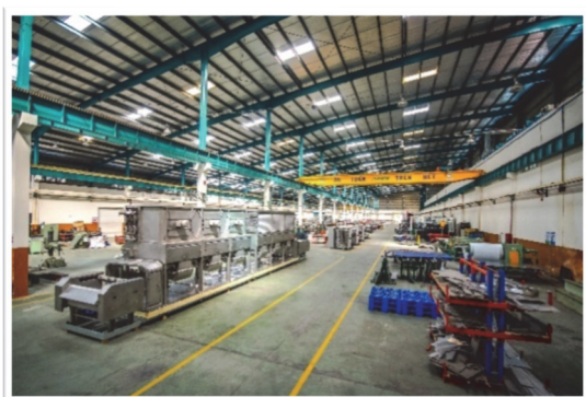
Tổng quan nhà máy cơ điện
