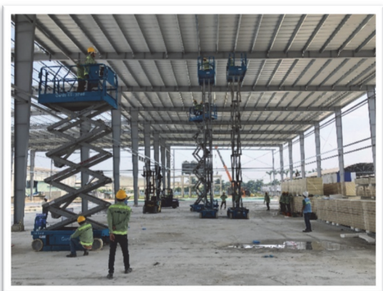
Chuẩn bị lắp kho lạnh
