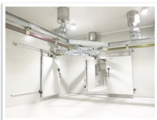
Cung cấp & lắp đặt hệ thống cửa
