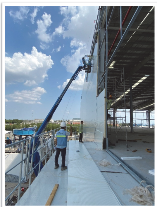
Lắp đặt nhà xưởng
