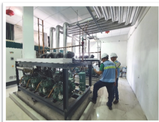
Lắp đặt hệ thống lạnh Freon
