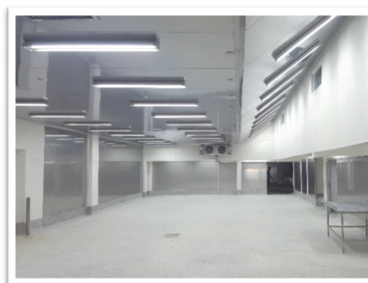
Lắp đặt nhà máy chế biến RTE
