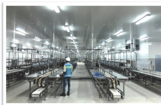
Lắp đặt dây chuyền sản xuất cá
