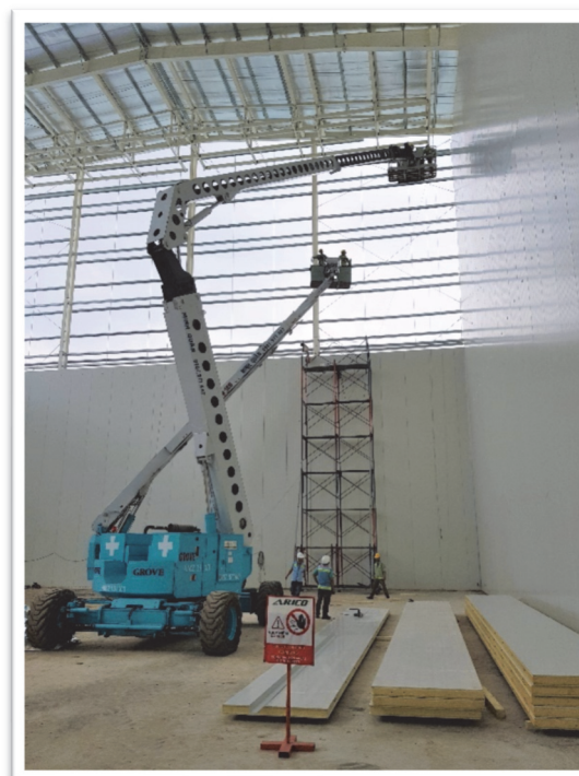
Lắp đặt kho lạnh tự động
