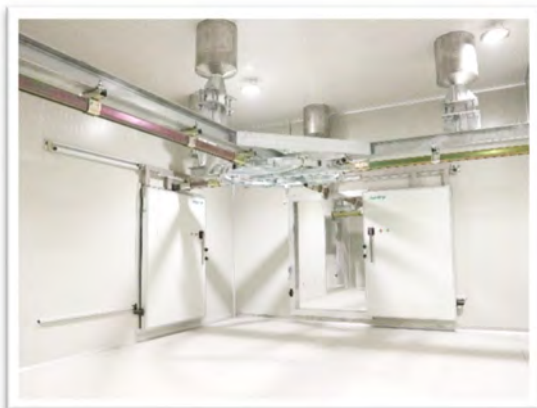
Cung cấp & lắp đặt hệ thống cửa
