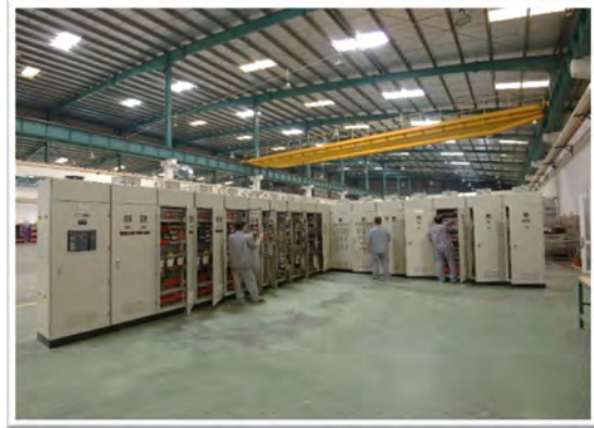
Khu vực lắp đặt tủ điện
