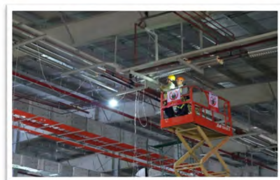
Lắp đặt đường ống hệ thống lạnh
