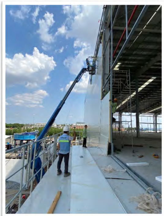
Lắp đặt nhà xưởng
