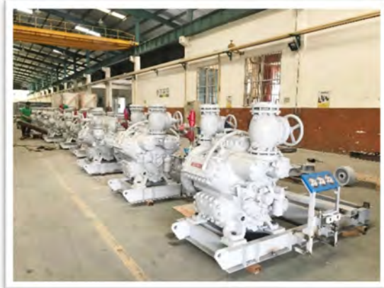
Khu vực tập lắp đặt máynén
