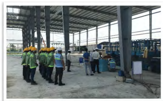
Chuẩn bị lắp dựng kho lạnh
