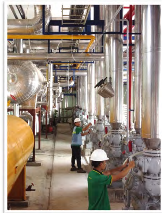
Vận hành hệ thống lạnh
