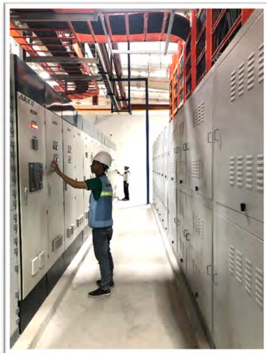
Vận hành hệ thống điện
