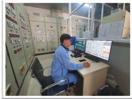
SCADA cho hệ thống lạnh
