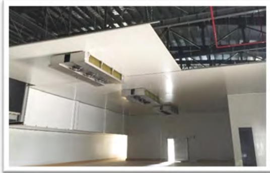
Lắp đặt nhà máy chế biến thực phẩm
