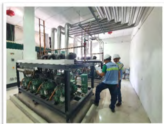
Lắp đặt hệ thống lạnh Freon
