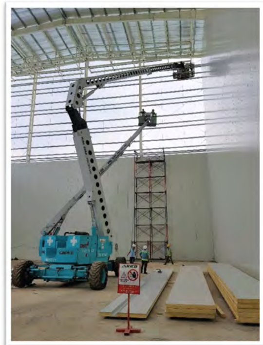
Lắp đặt kho lạnh tự động
