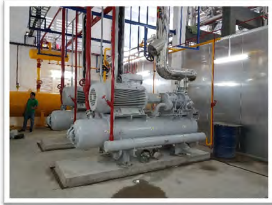
Hệ thống nước lạnh nhà máy sữa
