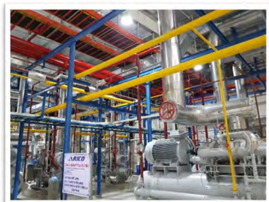
Lắp đặt hệ thống lạnh NH3
