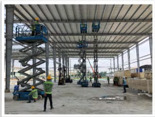
Chuẩn bị lắp kho lạnh
