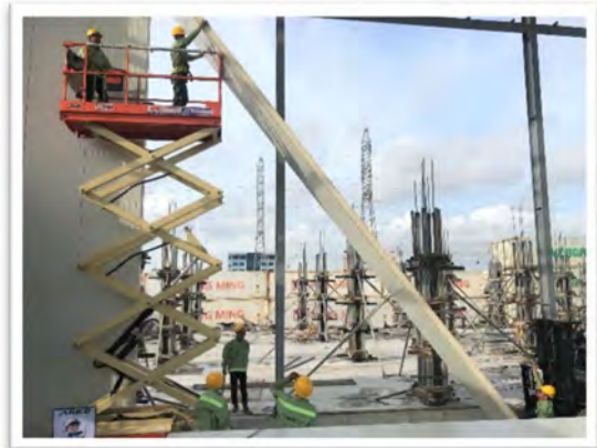
Lắp dựng kho lạnh
