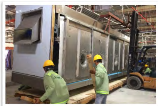
Lắp đặt IQF tầng sôi cho trái cây
