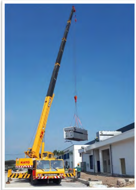
Lắp đặt dàn ngưng
