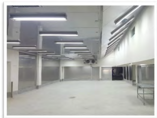
Lắp đặt nhà máy chế biến RTE
