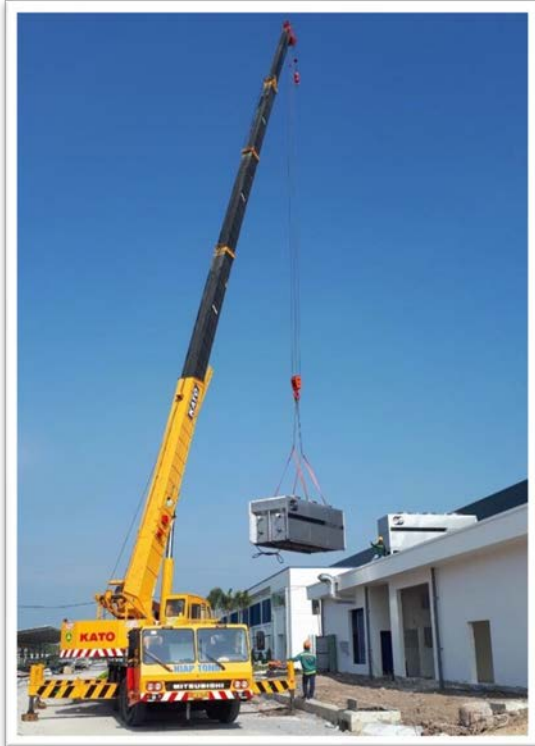
Lắp đặt dàn ngưng
