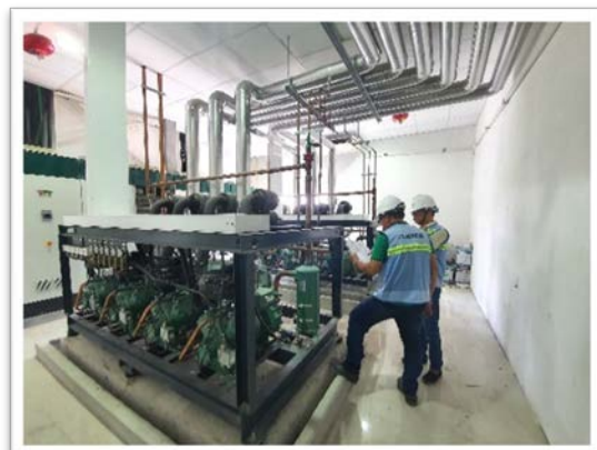
Lắp đặt hệ thống lạnh Freon
