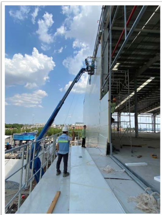
Lắp đặt nhà xưởng
