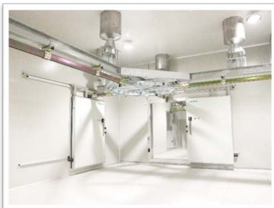
Cung cấp & lắp đặt hệ thống cửa
