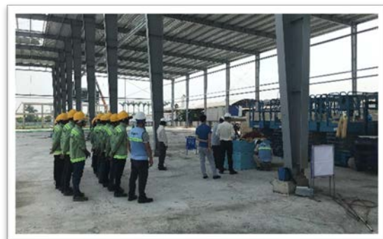
Chuẩn bị lắp dựng kho lạnh
