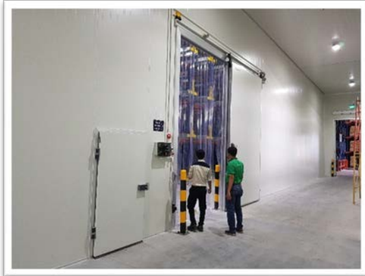
Lắp đặt cửa cách nhiệt
