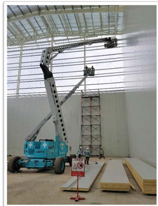
Lắp đặt kho lạnh tự động
