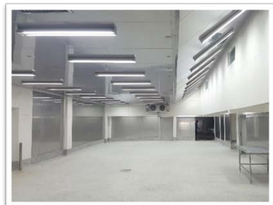
Lắp đặt nhà máy chế biến RTE
