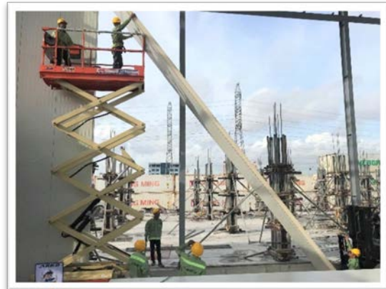
Lắp dựng kho lạnh
